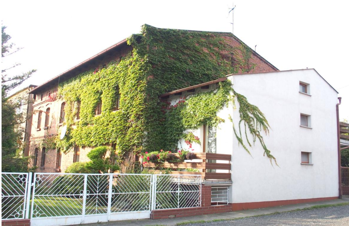
Widok budynku od południowego - wschodu
