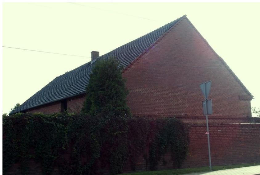
Widok budynku od północnego - wschodu
