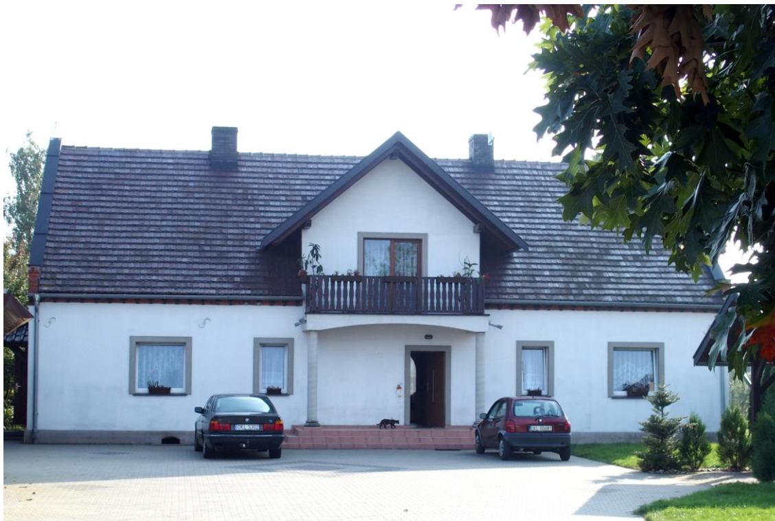
Widok budynku od północy
