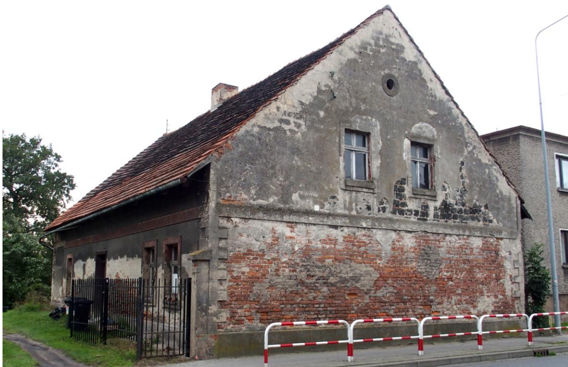
Widok budynku od północnego - wschodu
