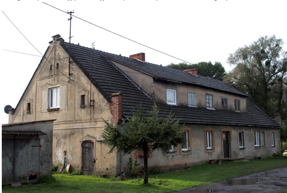
Widok budynku od północy
