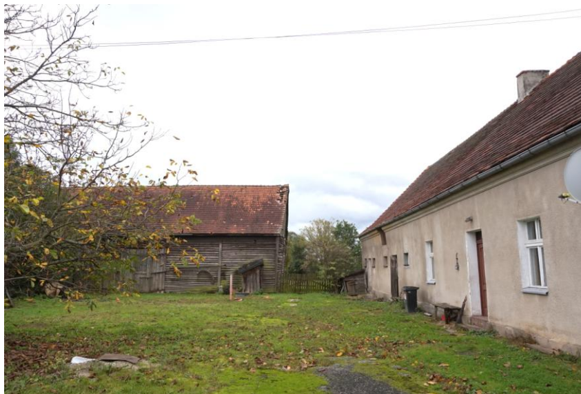
Widok budynku od północy
