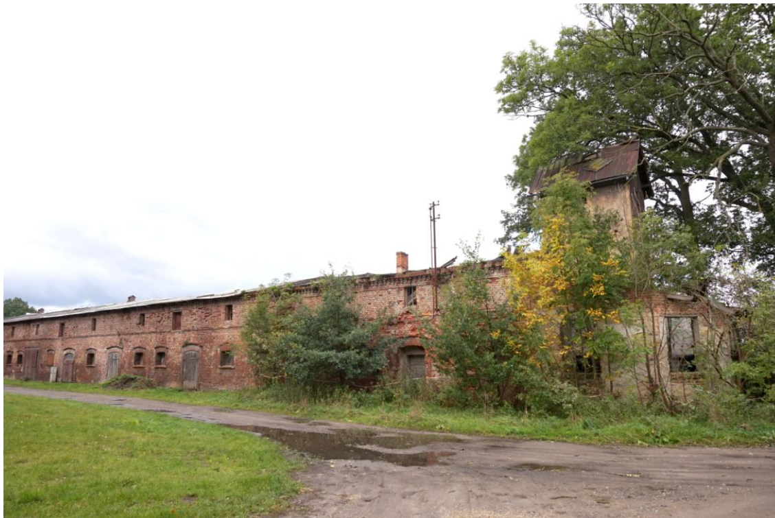
Widok budynku od północnego - wschodu
