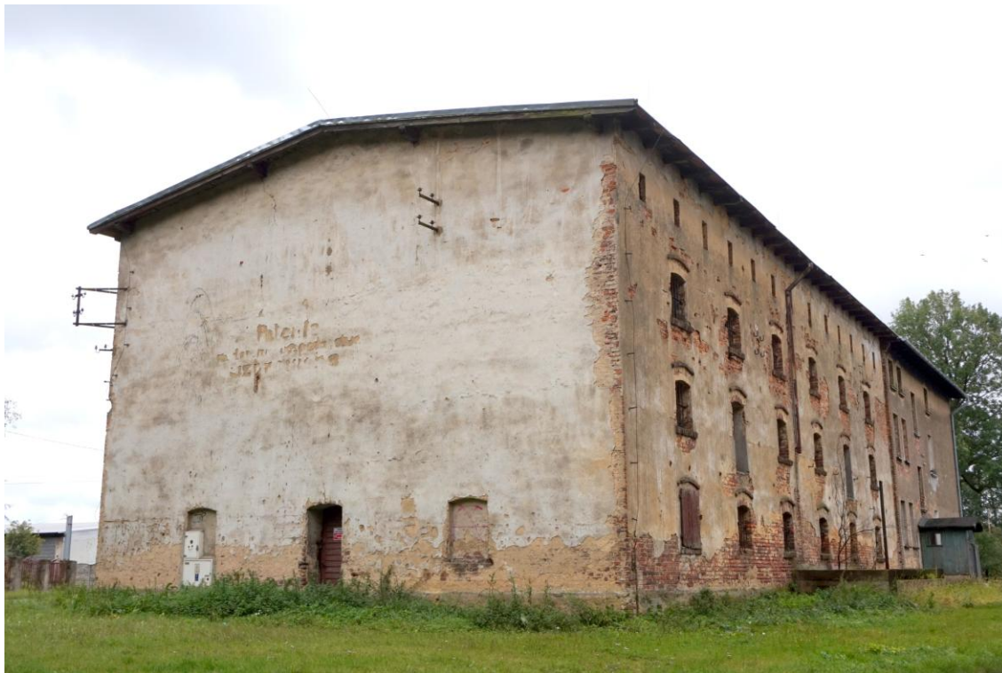
Widok budynku od północy
