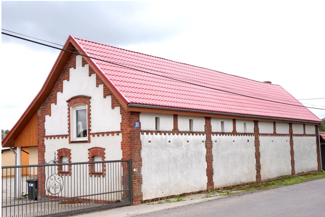
Widok budynku od północnego - zachodu
