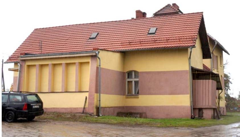
Widok budynku od wschodu
