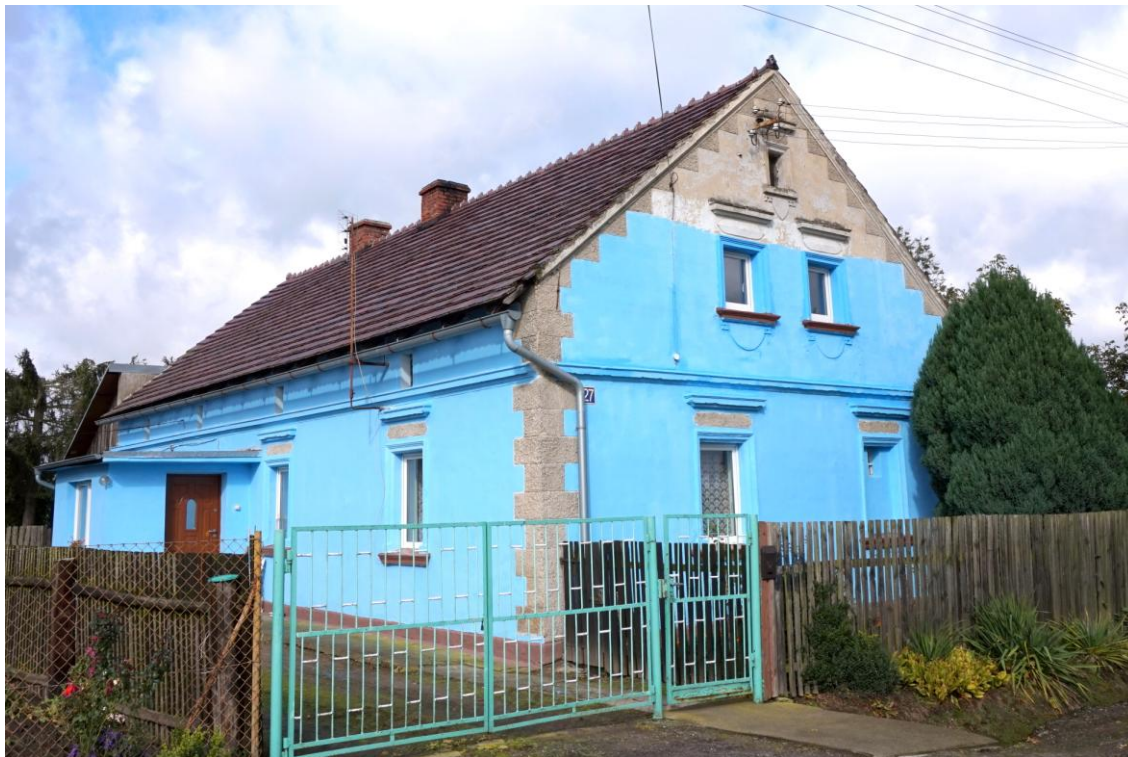
Widok budynku od południowego - wschodu
