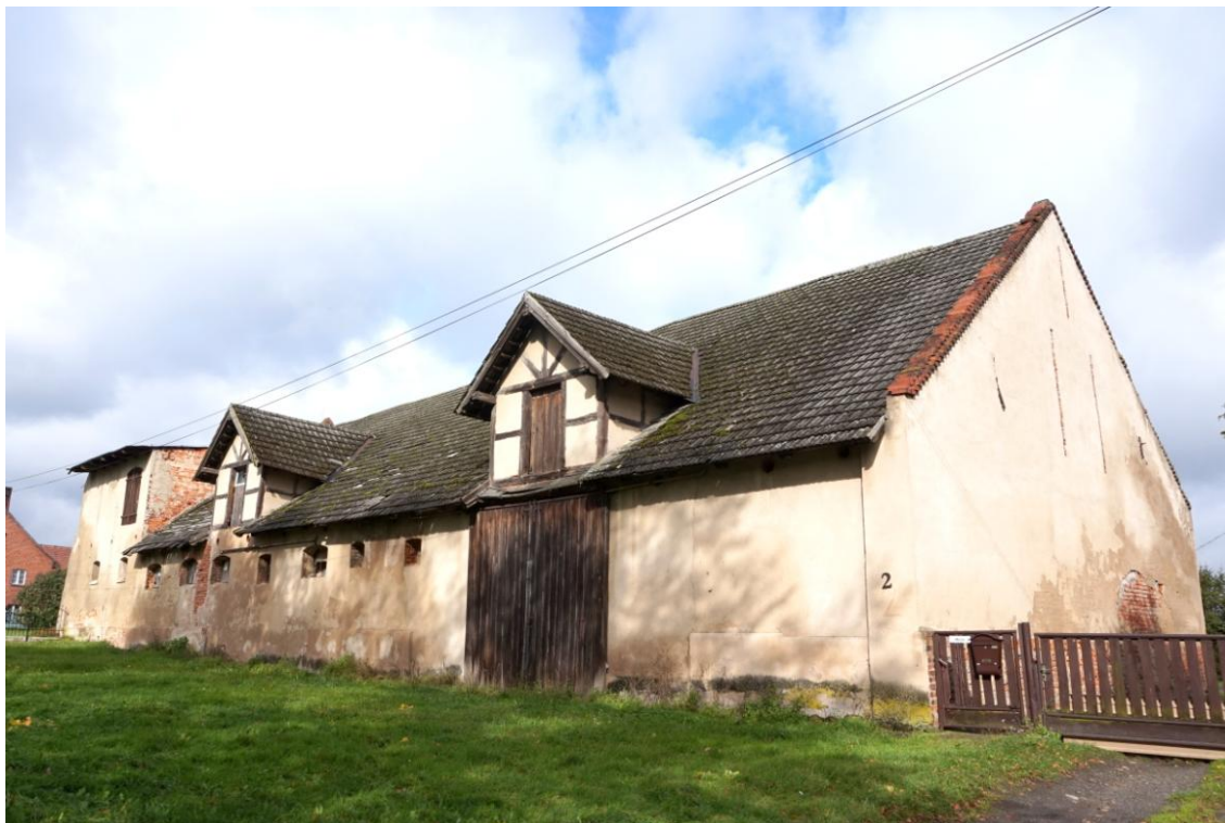
Widok budynku od południowego - wschodu
