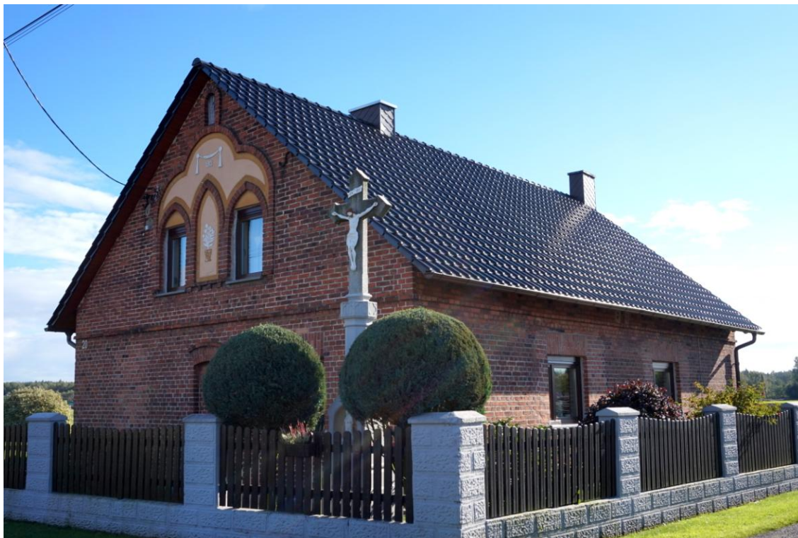
Widok budynku od północy
