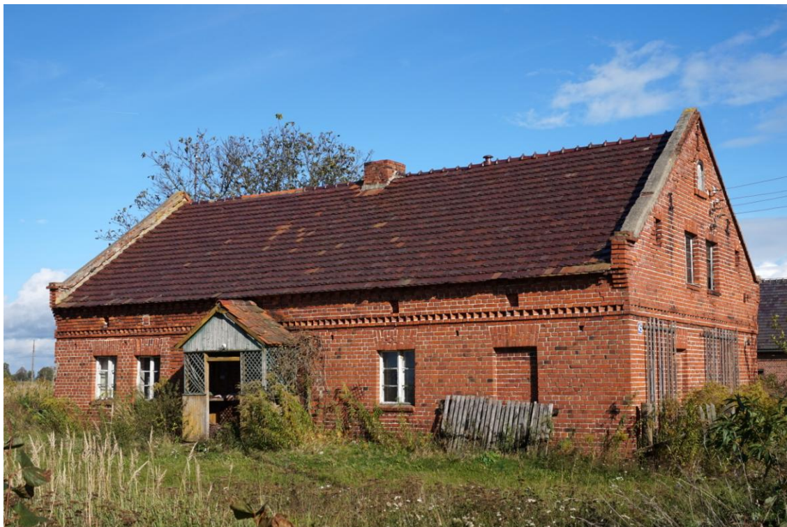
Widok budynku od południowego - zachodu
